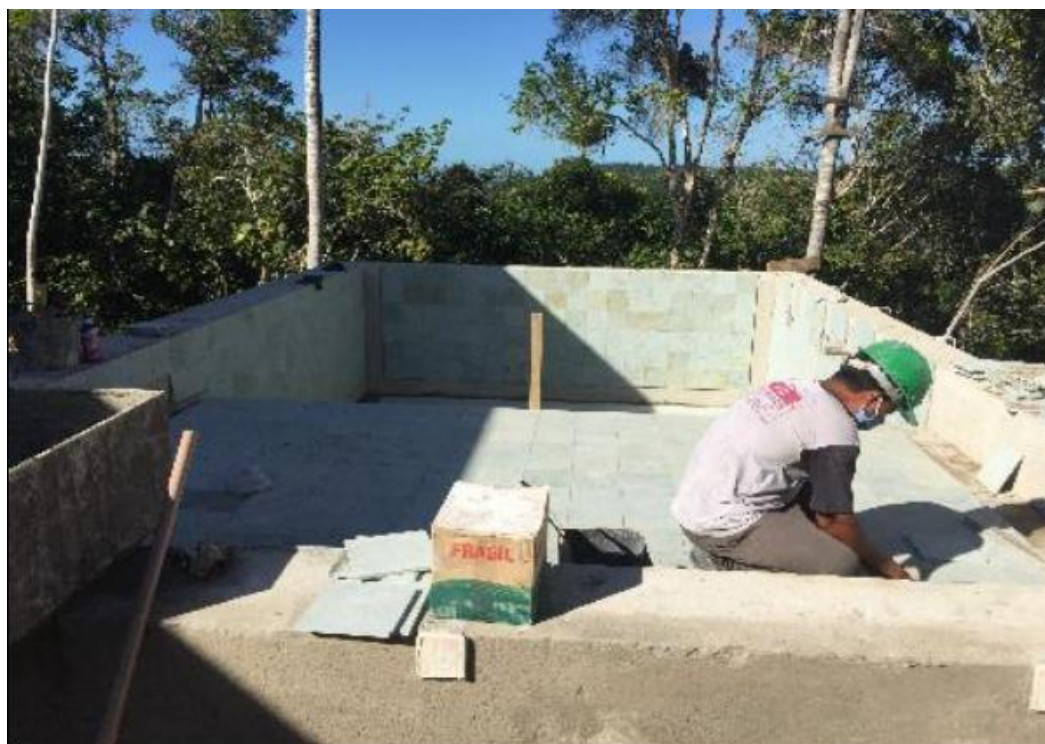
INSTALAÇÃO PEDRA HIJAU NA PISCINA
