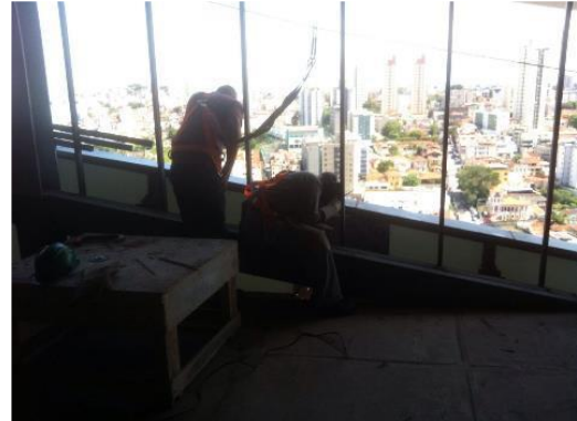
Fechamento da Fachada do 29o pavimento
