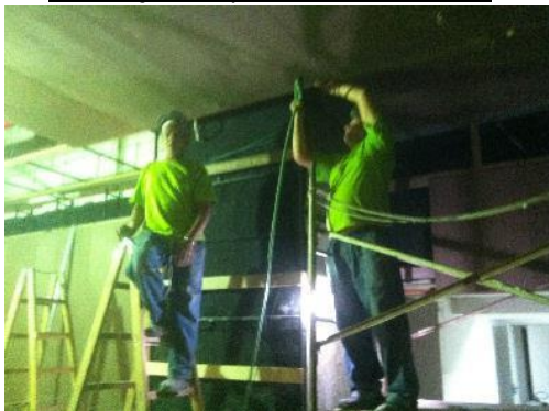
Instalação de painéis do auditório
