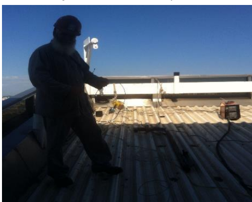
Instalação de Fibra Ótica para CFTV
