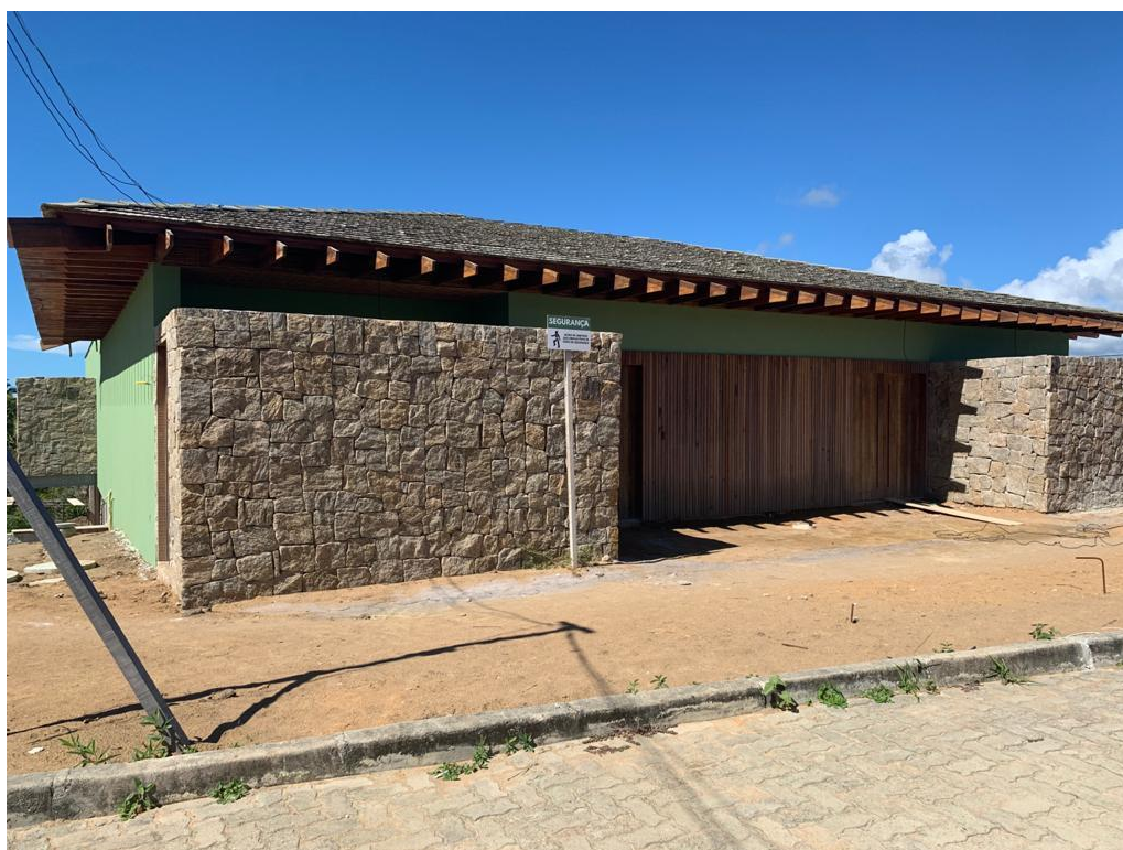
CASA 16 – Fachada Frontal
