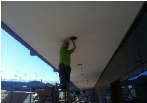
Instalação de luminárias externas - calçada
