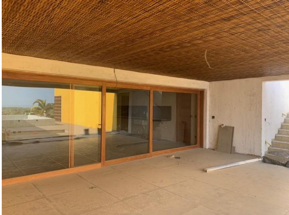
Vista interna da sala com destaque para acabamentos
