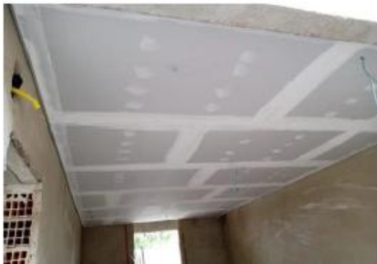
APLICAÇÃO DE GESSO
