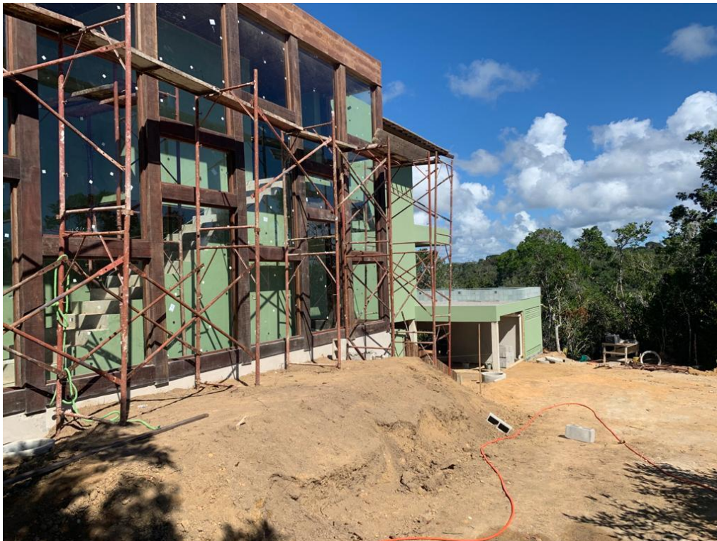
CASA 04 – Fachada do imóvel e preparação para o Paisagismo
