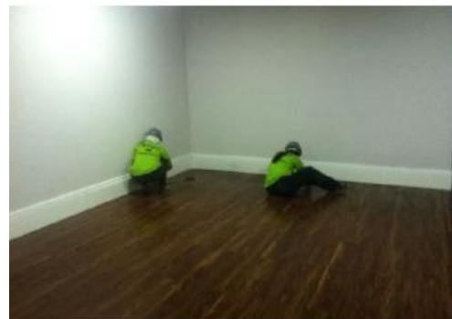
Limpeza dos pisos vinílicos do CC
