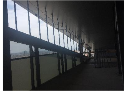
Fechamento de vão na estrutura metálica do 29o pavimento
