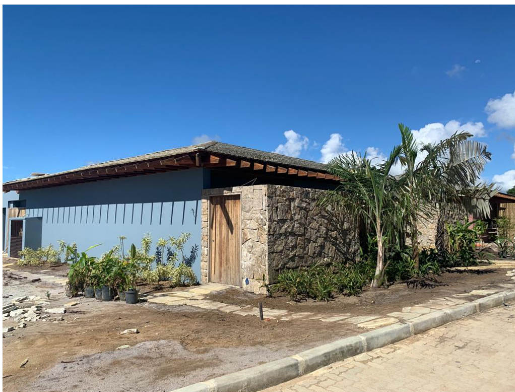
CASA 14 – Fachada e área externa
