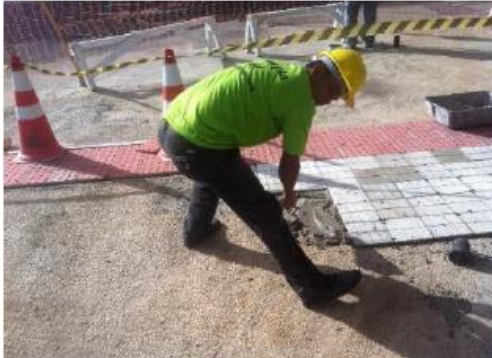
Instalação de ladrilhos da calçada
