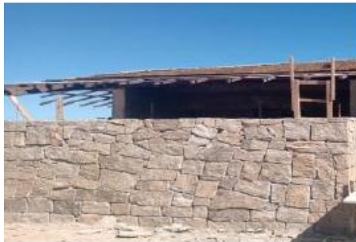
APLICAÇÃO DE PEDRA MOLEDO na FACHADA
