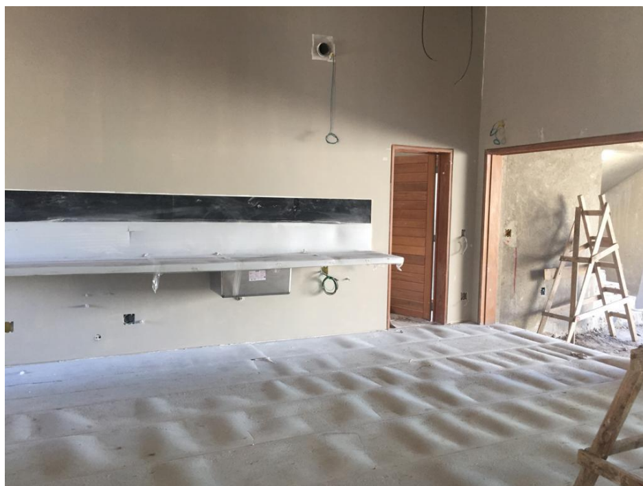
VISTA DA COZINHA
