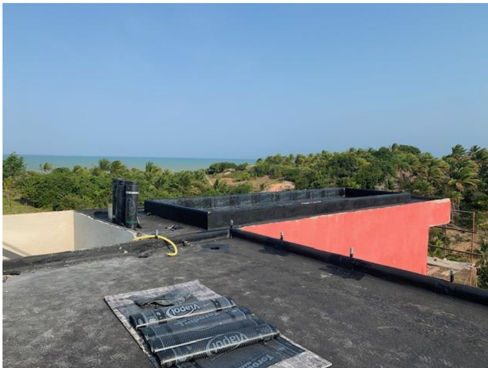
Vista externa com destaque para impermeabilização
