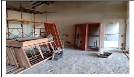
CAIXILHOS DE MADEIRA NA OBRA PARA INSTALAÇÃO.
