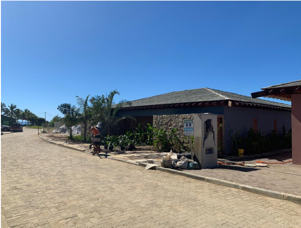
CASA 14 – Fachada Frontal
