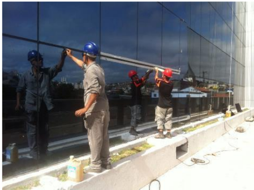
Aplicação de Silicone Vidros da Fachada
