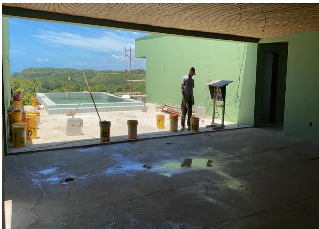
CASA 16 – Término da Pintura Externa
