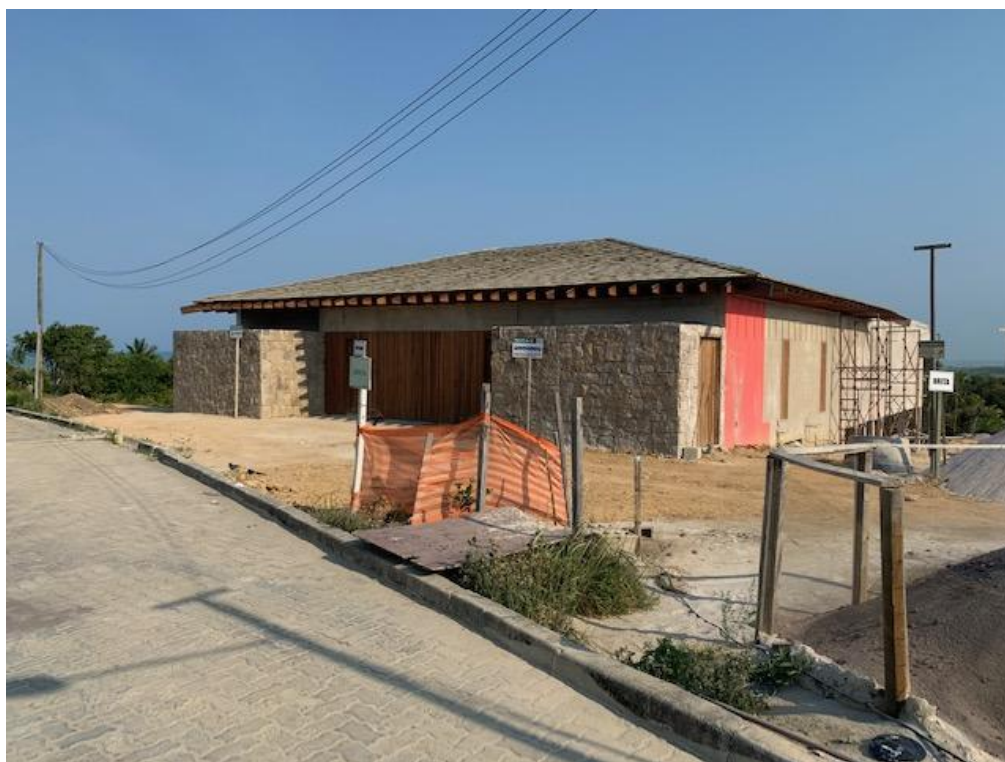
Fachada com detalhes do acabamento frontal com pedras MOLEDO
