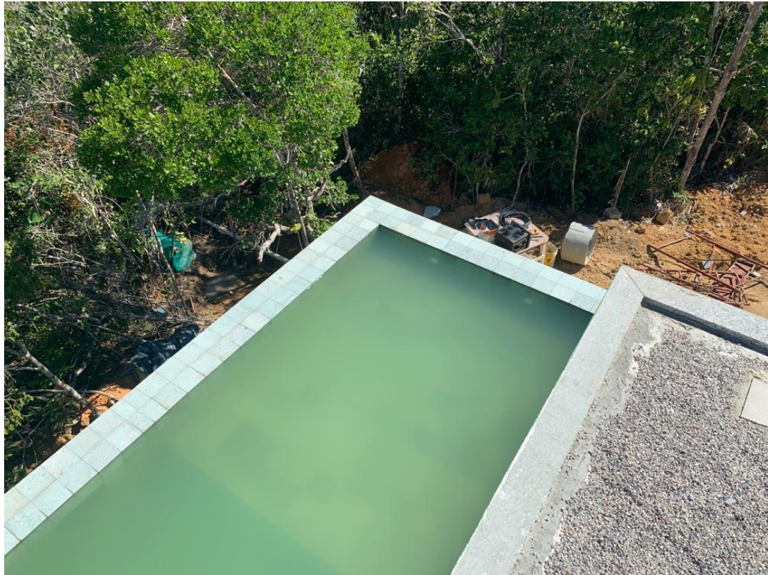
CASA 04 – Vista da suite de Fundos para Piscina
