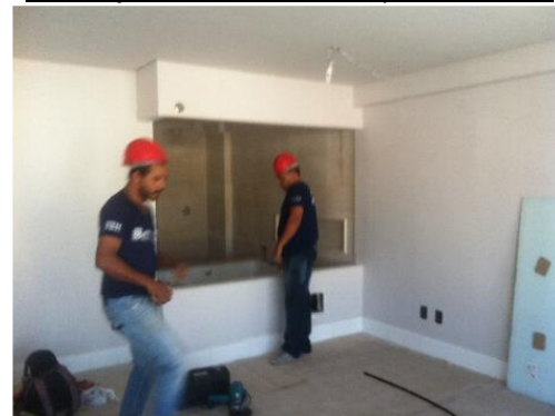
Instalação de vidros suítes presidenciais
